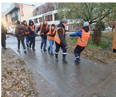
Работа со сваркой устранение повреждения и налаживание работы интернета.
